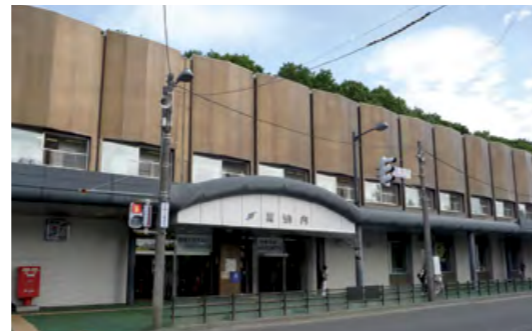
地下鉄真駒内駅(南北線 真駒内方面終点)
